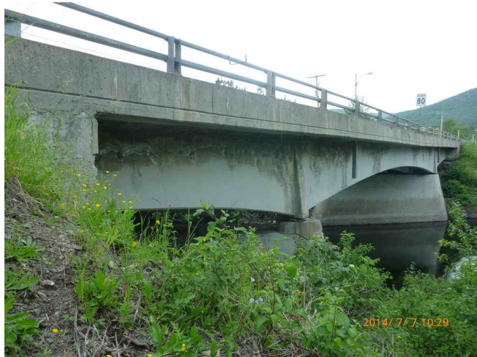
Figure 1 Présentation de l'ouvrage existant
